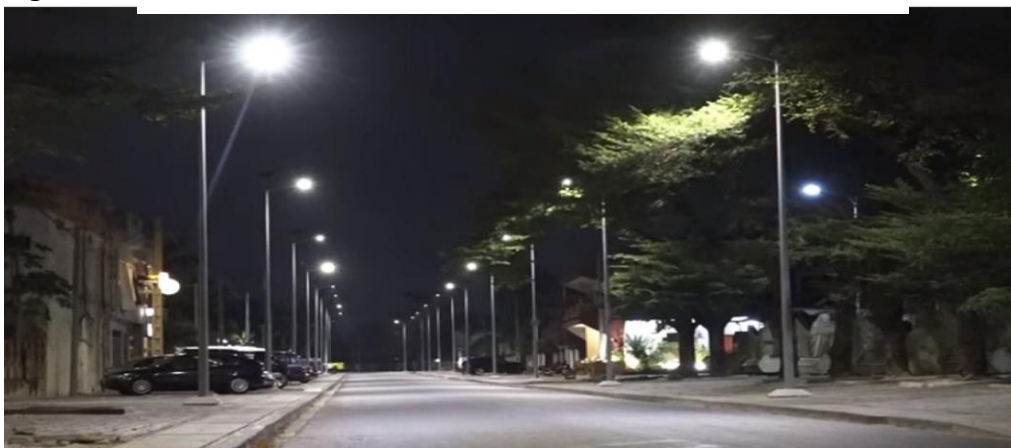
Une rue asphaltée à Cotonou vue de nuit
